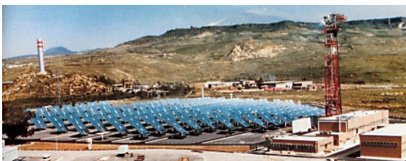
Figura 2a – La centrale di Adrano (Catania) di 1MWe in esercizio dal 1981 al 1984
