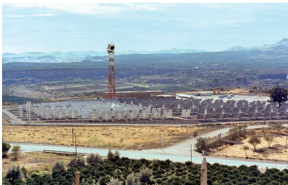
Figura 2. EURELIOS (Adrano, Catania), la prima centrale al mondo a concentrazione puntuale Fresnel (o a torre e campo specchi) a immettere nel 1981 energia elettrica termica solare in una rete nazionale (foto 1980, Museo dell'Industria e del Lavoro di Brescia, www.musil.bs.it ).
